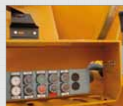
5 Painel de controle externo
